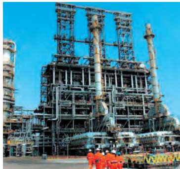
Рис. 43.7. Колонна крекинга нефти на Одесском нефтеперерабатывающем заводе
